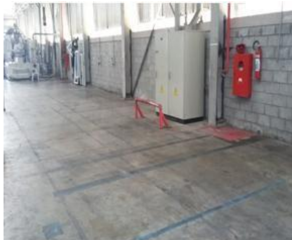
Figura 6 - Área de Produto Acabado (Antes)
