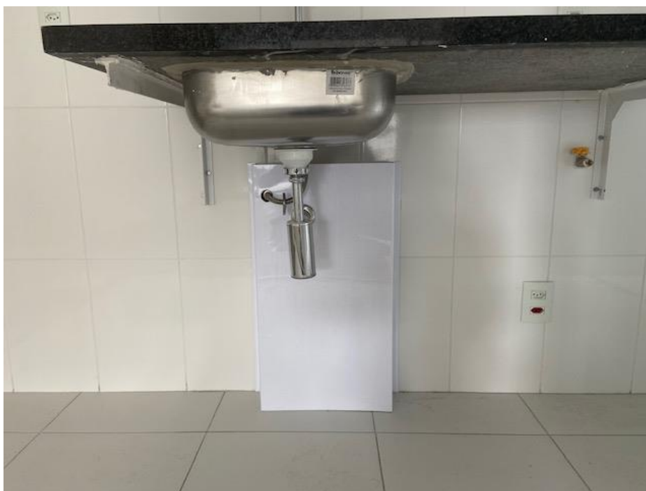
Figura 6: Prolongamento da haste metálica
