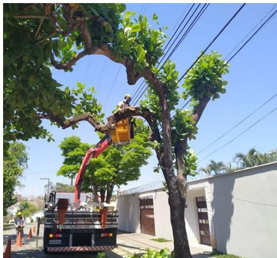
Figura 3 – Poda de redes áreas de distribuição – Média e baixa-tensão
