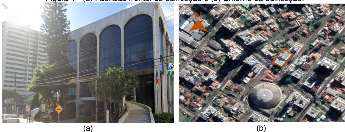
Figura 1 - (a) Fachada frontal da edificação e (b) Entorno da edificação.
