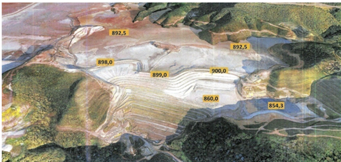
Figura 3 - Imagens mostrando a vista geral da Barragem de Fundão pré-rompimento com os números das cotas de elevação em relação ao nível médio do Mar
